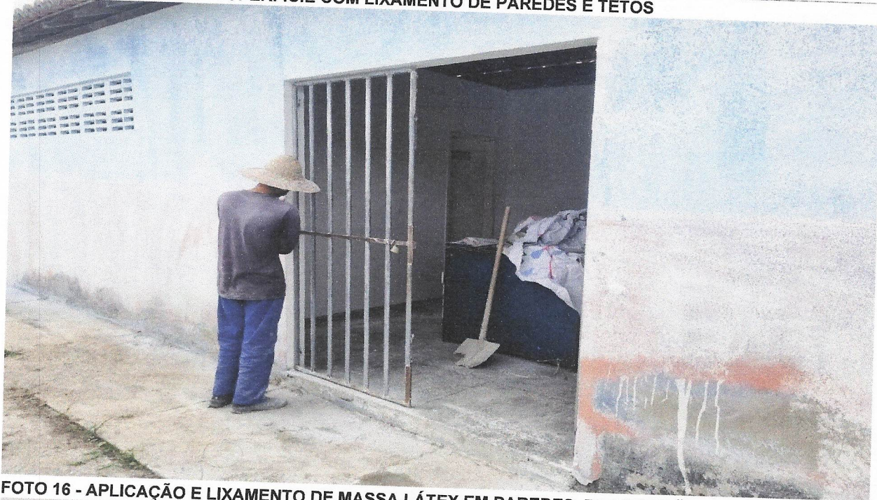
FOTO 15 - PREPARO DE SUPERFÍCIE COM LIXAMENTO DE PAREDES E TETOS
