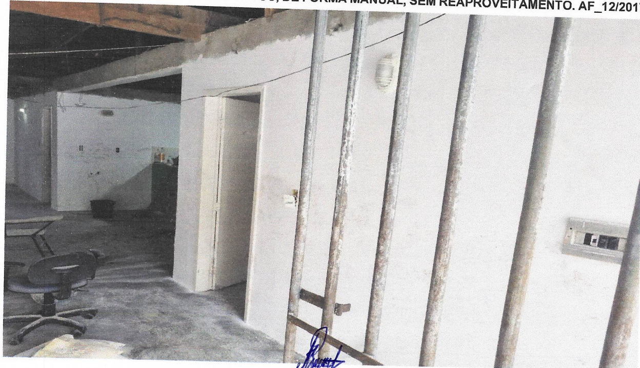
FOTO 08 - REMOÇÃO DE CABOS ELÉTRICOS, DE FORMA MANUAL, SEM REAPROVEITAMENTO. AF_12/2017
