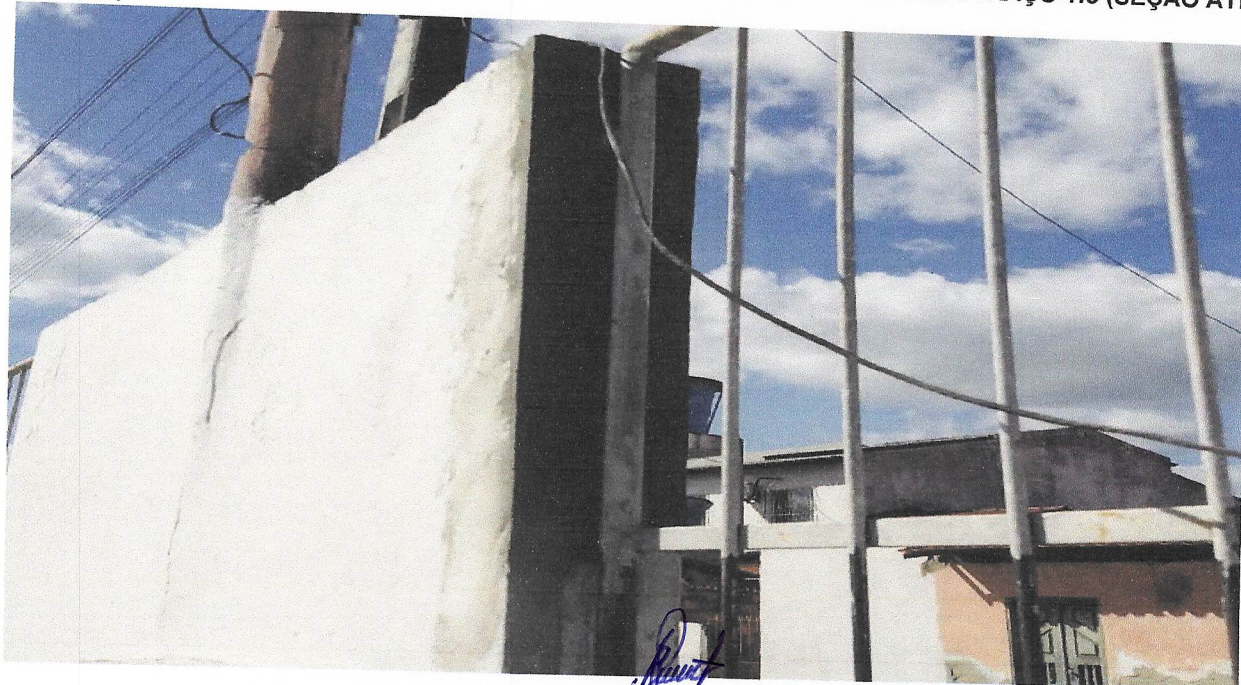
FOTO 02 - TRATAMENTO DE FISSURAS COM ARGAMASSA DE CIMENTO E AREIA TRAÇO 1:3 (SEÇÃO ATÉ 5 X 5 CM)
