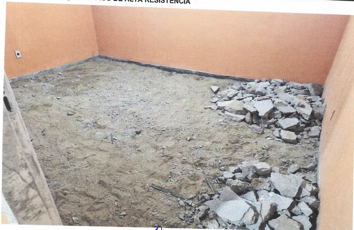
FOTO 04 - DEMOLIÇÃO DE PISO DE ALTA RESISTÊNCIA
