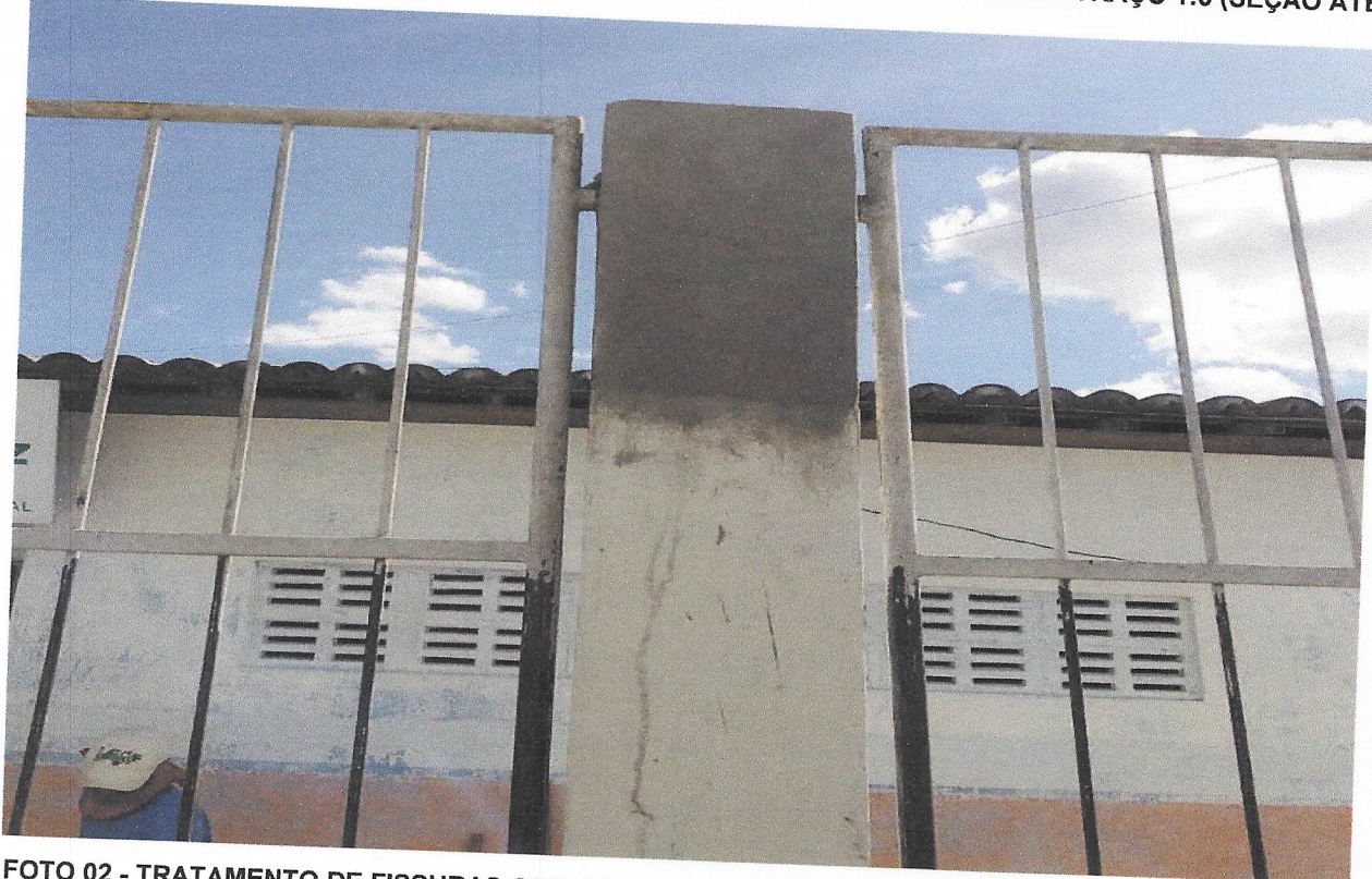
FOTO 02 - TRATAMENTO DE FISSURAS COM ARGAMASSA DE CIMENTO E AREIA TRAÇO 1:3 (SEÇÃO ATÉ 5 X 5 CM)
