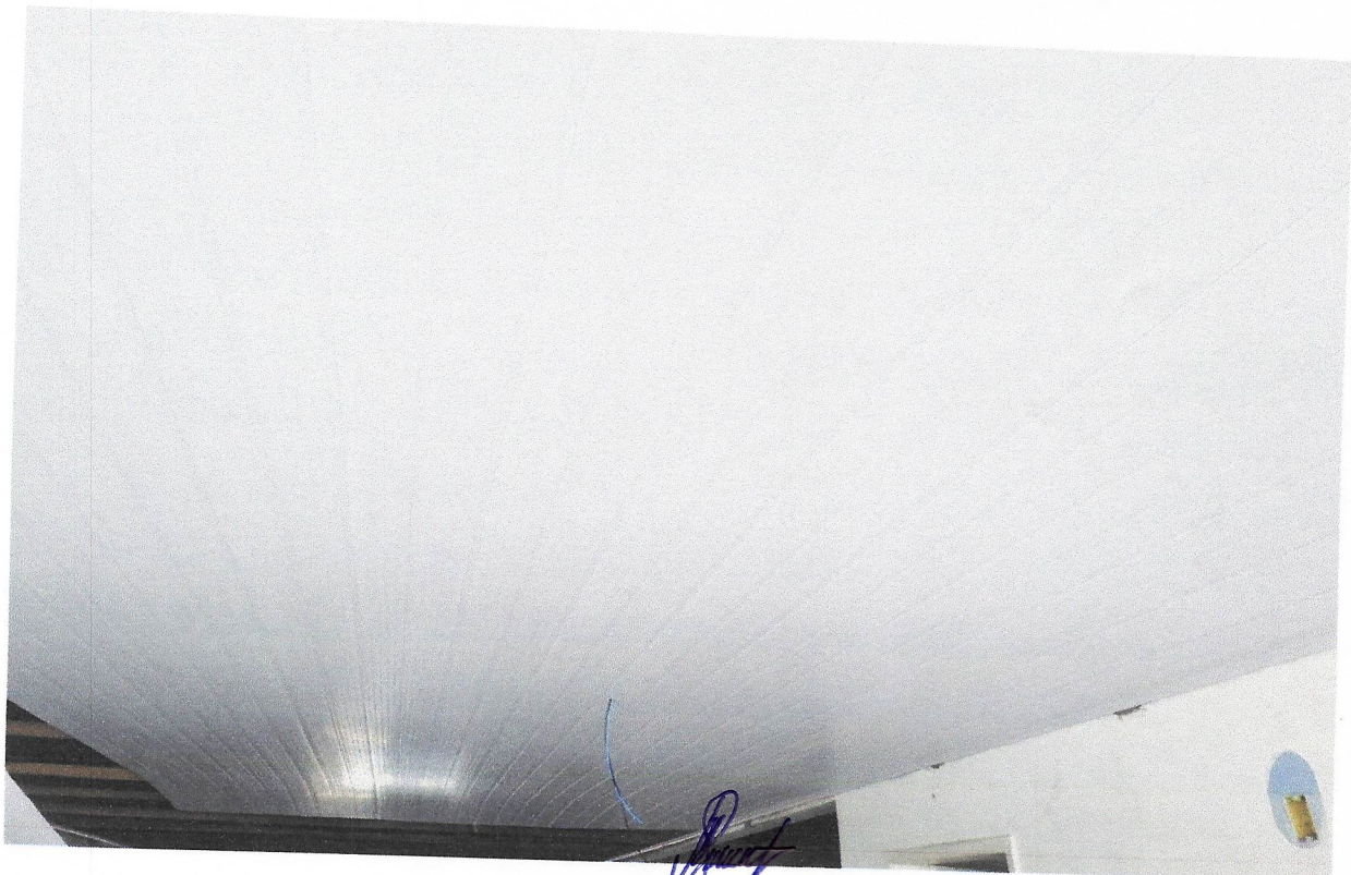
FOTO 24 - FORRO EM RÉGUAS DE PVC, FRISADO, PARA AMBIENTES RESIDENCIAIS, INCLUSIVE ESTRUTURA DE FIXAÇÃO. AF_05/2017_P
